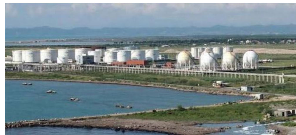
Figura 5.18 Zona e re për ruajtjen e hidrokarbureve dhe GPL në Porto Romano
