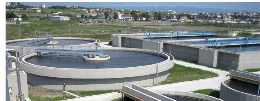
Figura 5.8 Impianti i ri i pastrimit të ujërave të zeza Durrësit
