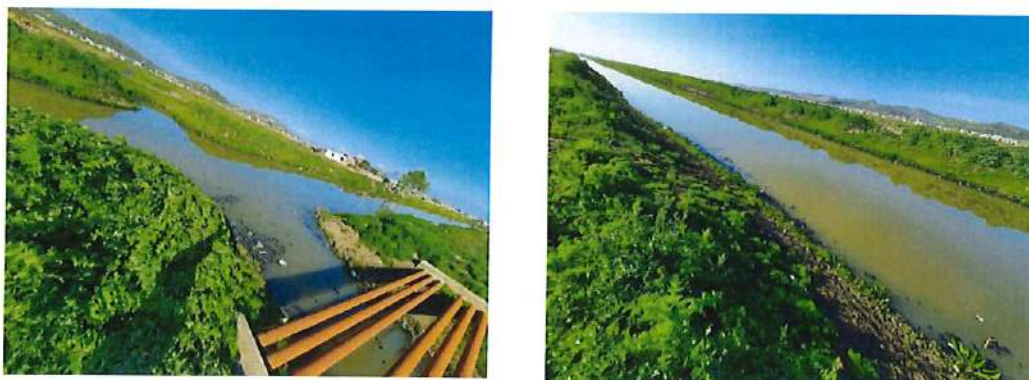
Figura 19. Kryqëzimi i kanalit dytësor me kanalin primar dhe pamje e kanalit primar
